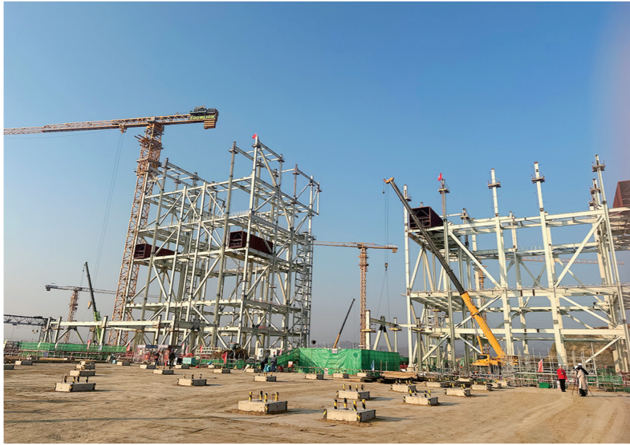
项目建设现场
