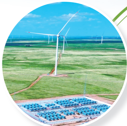
包头铝业燃煤自备电厂可再生能源替代达茂旗120万千瓦项目
